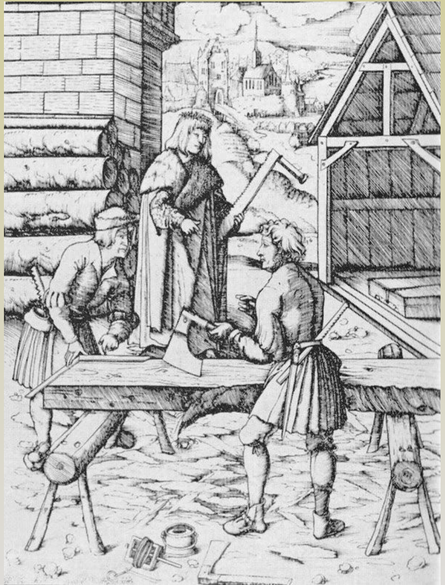
L'empereur germanique Maximilien visitant un chantier de charpente -1515 Métropolitan muséum -New York
